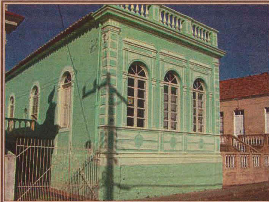
Exemplo típico de uma casa eclética, com platibanda de balaústres, cunhais almofadadas, janelas com arcos romanos, ombreiras carintias e recuos laterais. Na rua Voluntário Carpes, no centro da cidade, atual residência de dona Maria Adelaide Pinho Moreira.
